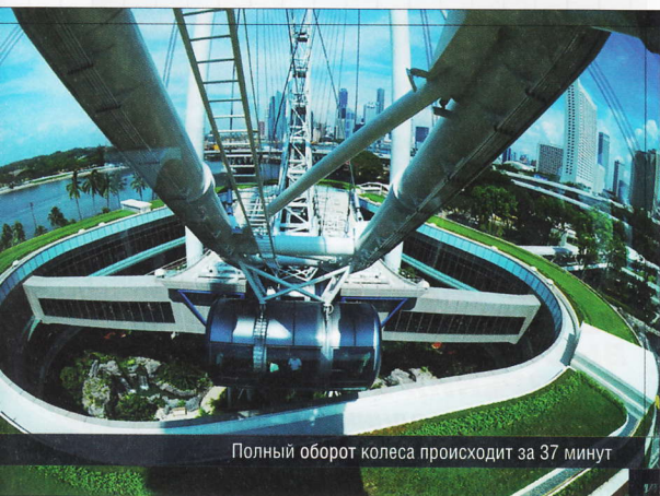
Само колесо поддерживают две колонны 2,85 м в диаметре
